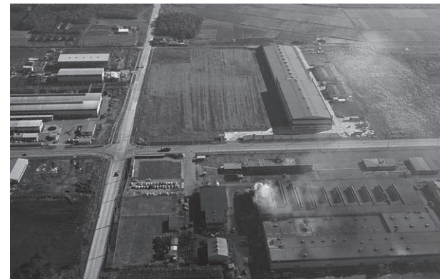
第1期工場完成の小山工場(1969年ごろ)
