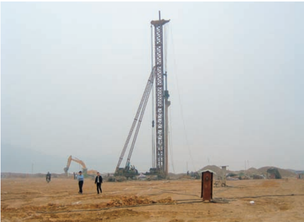
YBM敷地内をボーリング調査 Ground-boring survey at YBM
