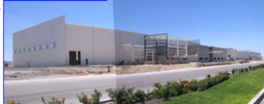
YAGM工場建設の様子
