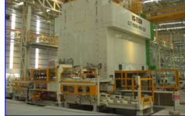
大型プレス機械設置工事の様子
